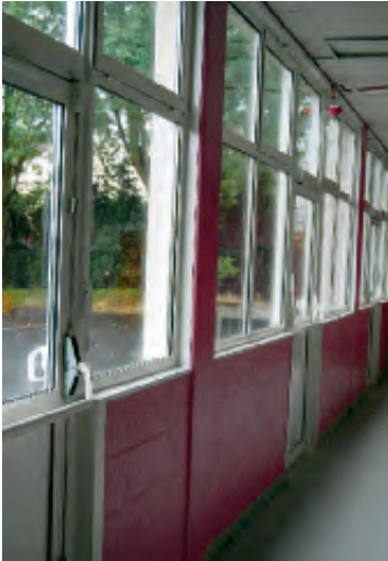
Remplacement des menuiseries à l'école primaire de Mondétour.
