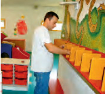
Mise en peinture des murs de la crèche la Farandole
