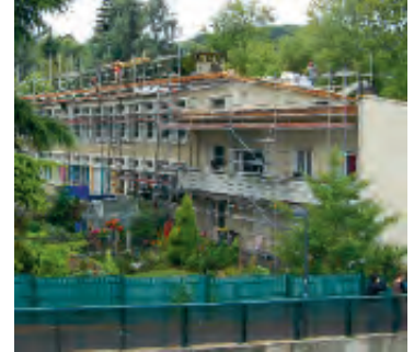
Réfection de la toiture de l'école maternelle du Guichet : un chantier impressionnant pour une meilleure isolation.
