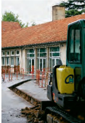
Travaux de raccordement à la chaudière centrale à l'école de Mondétour.
